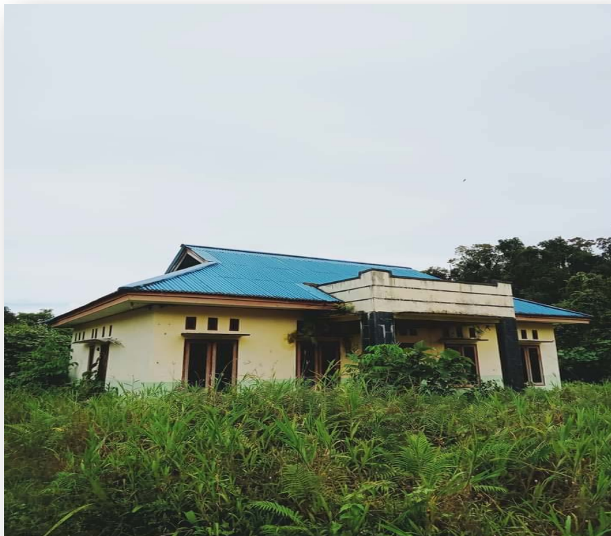
Gambar 10 Kondisi Kantor Kampung Maan di Distrik Aifat Utara
