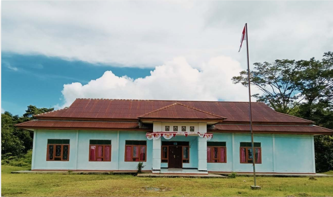
10). Kantor Distrik Aifat Utara
