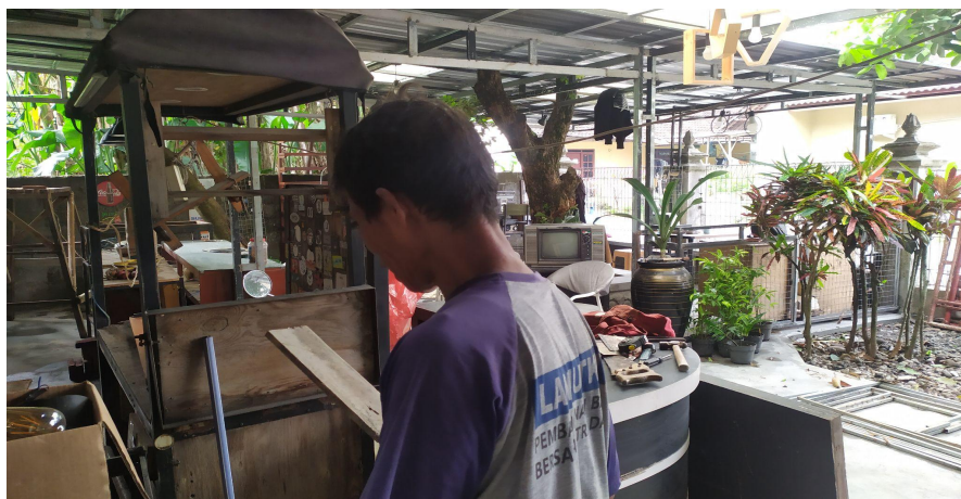
Keterangan foto 4: Pembangunan Cafe Teko'Su di Gejayan.
