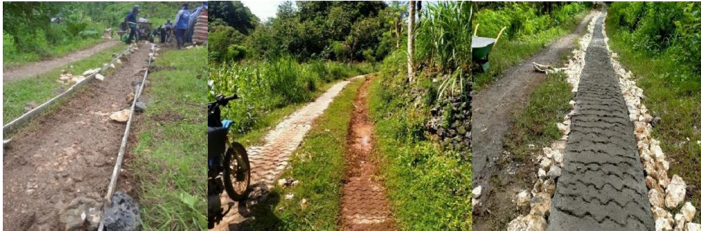
Gambar IV.2. Perbaikan Infastruktur Jalan Tani
