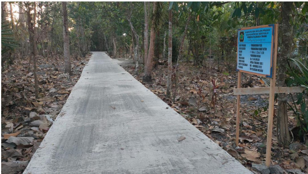
Keterangan: Pembangunan Jalan di Padukuhan Bulak
