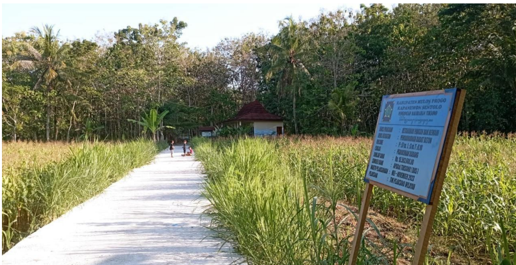
Keterangan: Pembangunan Jalan di Padukuhan Karang
