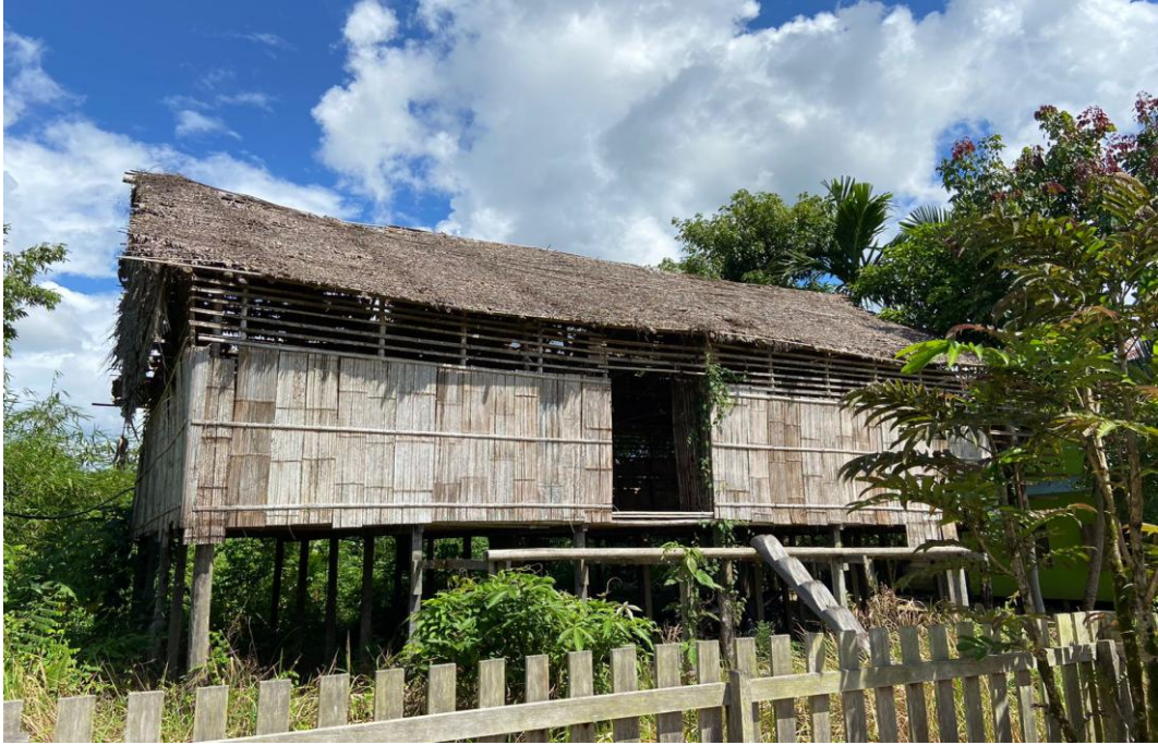
Pembangunan Rumah Adat Dayak Desa Bali Agas
