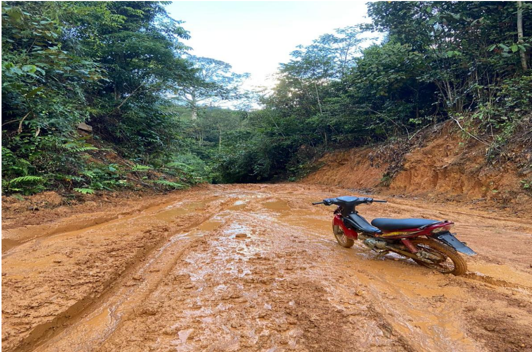
Pembangunan Jalan Antar Dusun Sungai Duri Ke Desa Balai Agas
