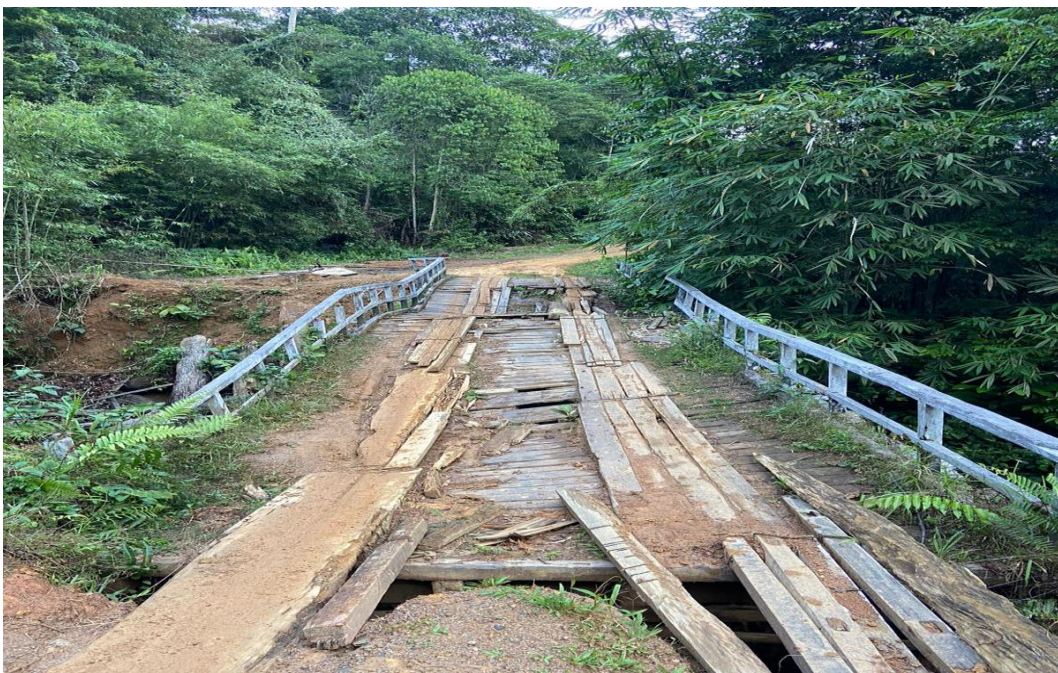
Pembangunan Jembata Dusun Sungai Duri Ke Desa Balai Agas
