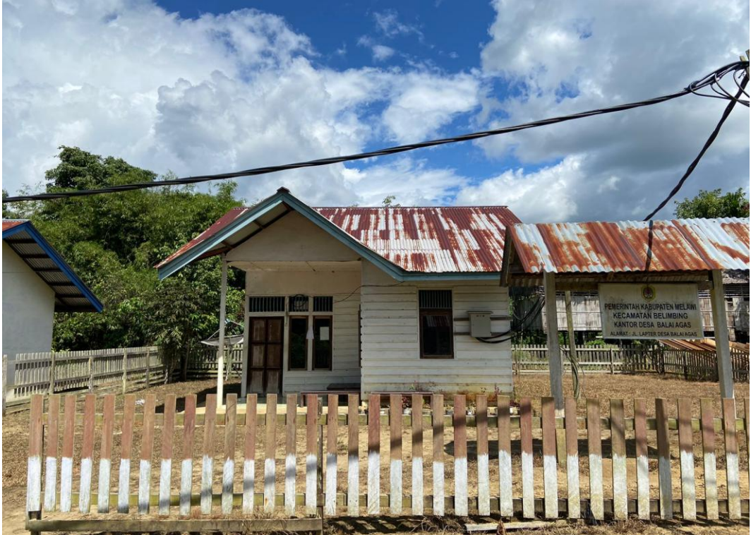
Pembangunan Kantor Desa Balai Agas
