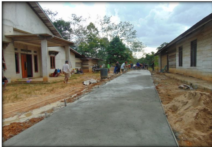
Dokumentasi Jalan Rabat Beton Dusun Jadi Mulya 50%
