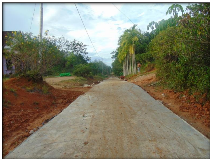
Dokumentasi Jalan Rabat Beton Dusun Suka Jadi 100%
