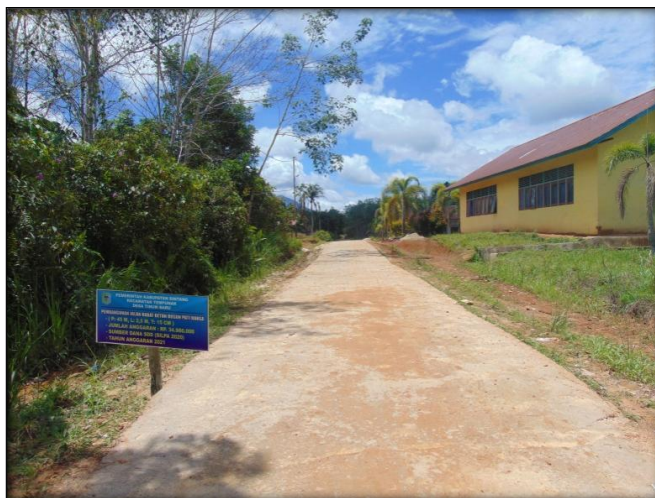
Dokumentasi Jalan Rabat Beton Dusun Batu Raya 100%
