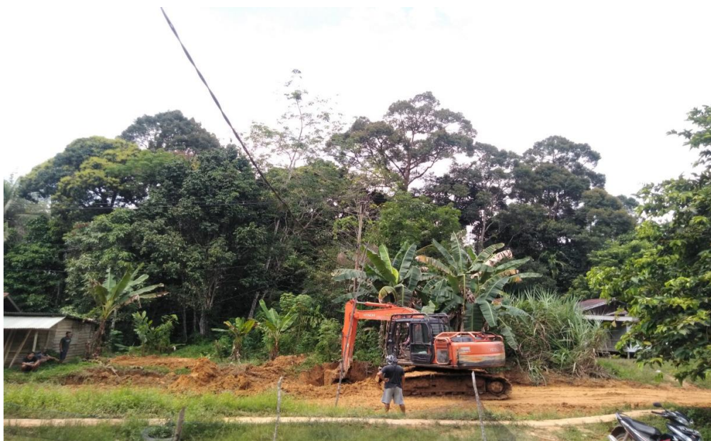
Gambar 1. 1 Perbaikan Jalan Desa
