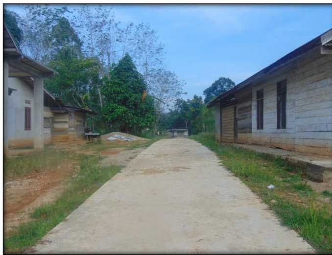
Dokumentasi Jalan Rabat Beton Dusun Jadi Mulya 100%
