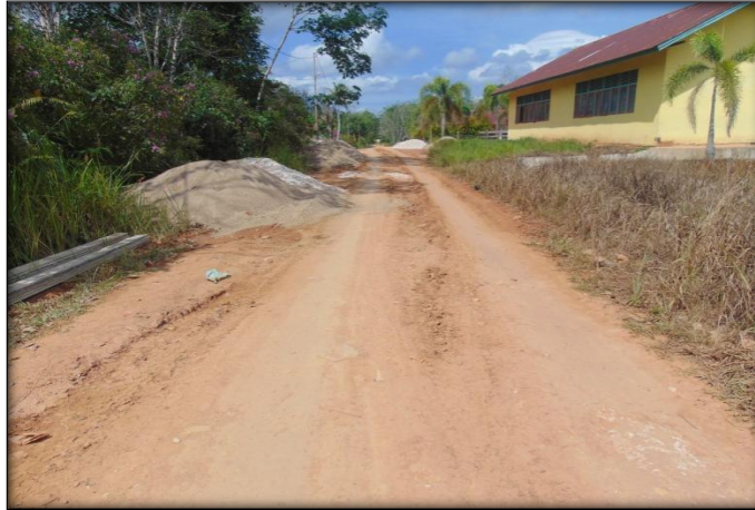
Dokumentasi Jalan Rabat Beton Dusun Jadi Mulya 0%
