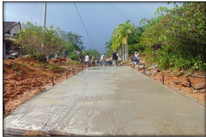
Dokumentasi Jalan Rambat Beton Dusun Suka Jadi 50%
