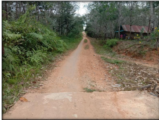
Dokumentasi Jalan Rabat Beton Dusun Batu Raya 0%
