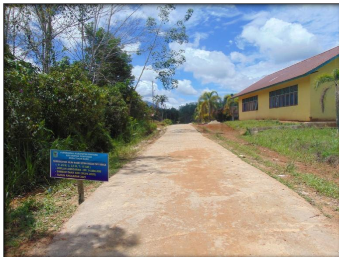
Dokumentasi Jalan Rabat Beton Dusun Pati Ransa 100%
