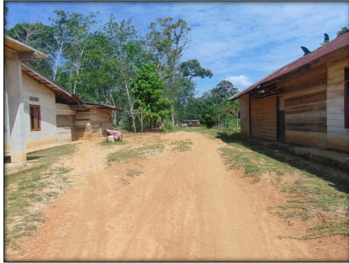
Dokumentasi Jalan Rambat Beton Dusun Suka Jadi 0%
