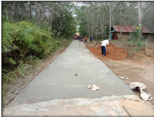
Dokumentasi Jalan Rabat Beton Dusun Batu Raya 50%
