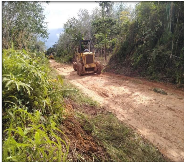
Dokumentasi Penelitian Pengusuran Jalan Menuju Dusun Batu Raya Menggunakan Alat Berat
