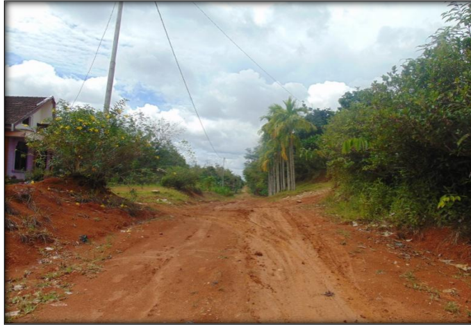
Dokumentasi Jalan Rabat Beton Dusun Pati Ransa 0%
