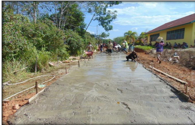
Dokumentasi Jalan Rabat Beton Dusun Pati Ransa 50%
