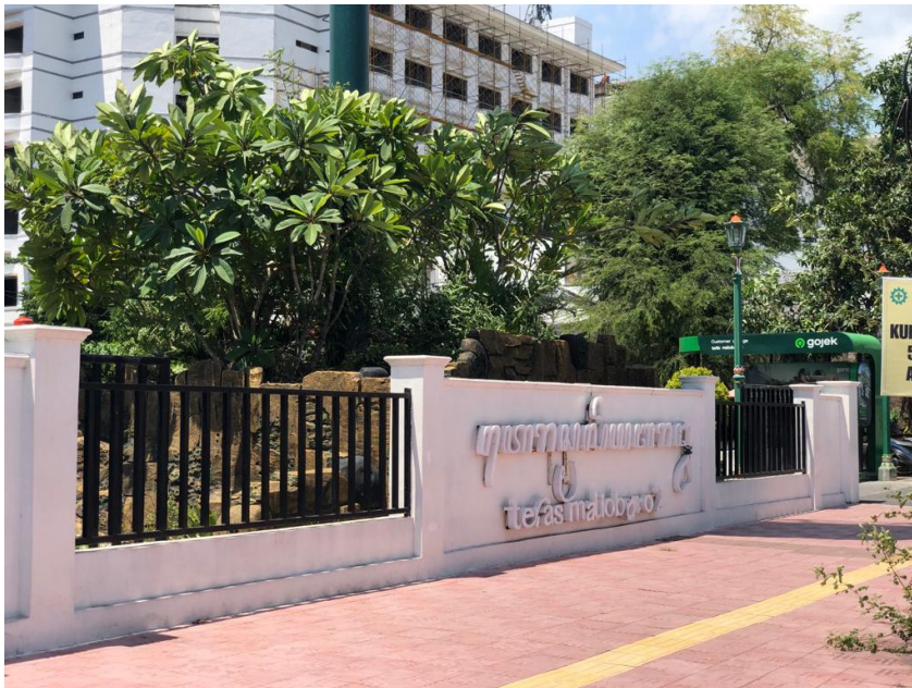
Gambar 4 : Foto Pintu Masuk Belakang Teras Malioboro 2 (Dokumen Pribadi, diambil pada tanggal 19 Desember 2023 pukul 12.00 WIB)
