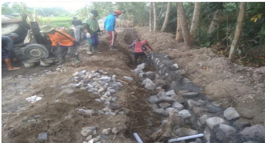
Gambar 2.4. Pembuatan talud pengairan
