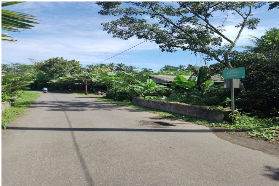
Jalan Kembali dari arah sungai ke Pendopo Tua
