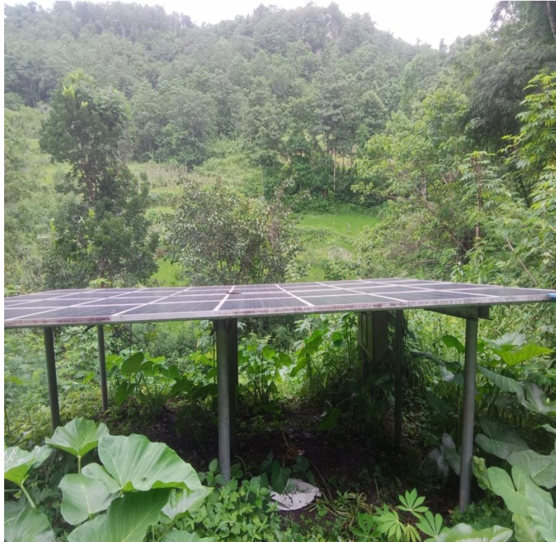
Gambar 7. Dokumentasi Modul tenaga surya sebagai alat pengangkat air dari dalam Goa
