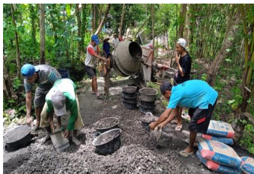
Pengawasan Pada Pelaksanaan Pengecoran Jalan
