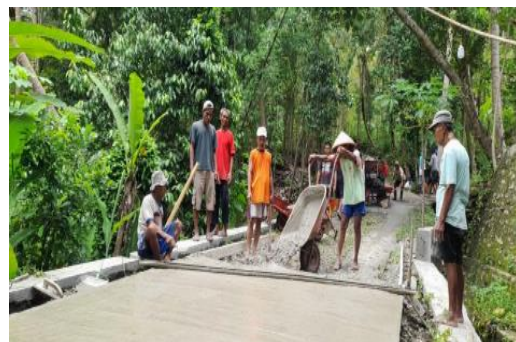
Pengecoran Jalan Padukuhan Jambean
